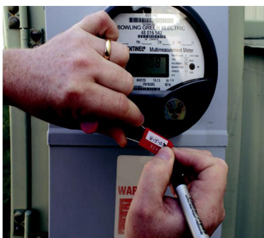
Fig. 1.7 Sealing Meter
